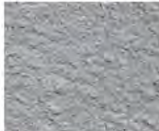
CSP 5 (Medium Shot blasting)
